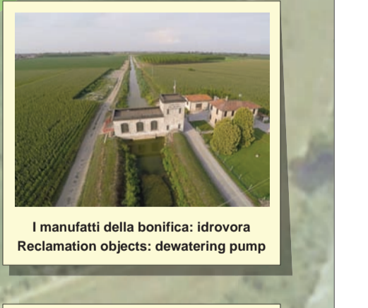
Manufatti della bonifica: idrovora Reclamation objects: dewatering pump
